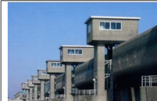
利根川河口堰
