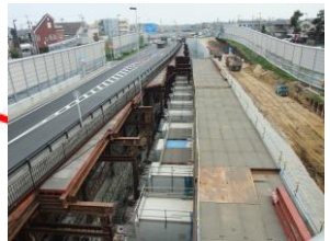
②先行整備区間1
