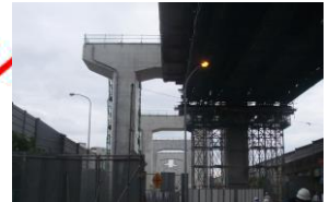
①小山高架橋工事
