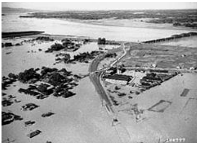
昭和 22 年（1947 年）9 月カスリーン台風が引き起こした氾濫
